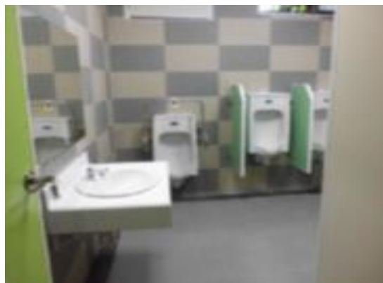
老舊廁所改善工程(7 棟建築物，總經費約 1 千 7 百萬元)
