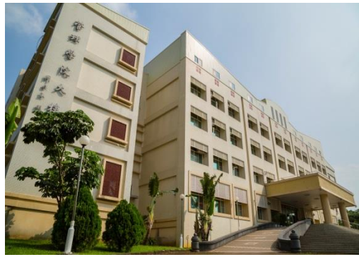
管理學院屋頂增建工程
