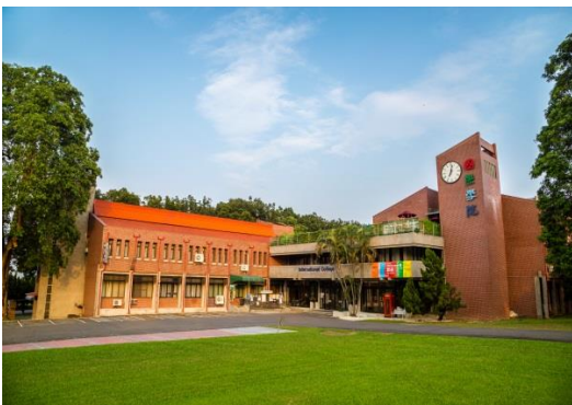
機械系、生機系、國際學院、車輛工廠等 4 棟建物整修工程
